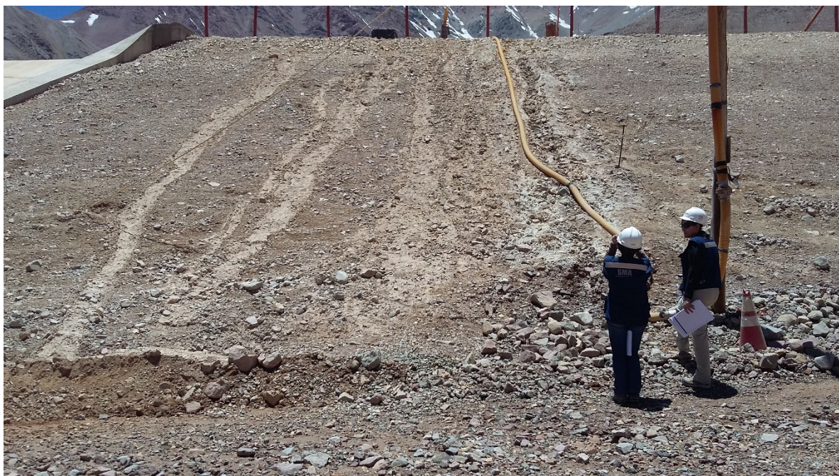
Imagen 3. Marcas de escurrimiento de aguas contactadas a un costado del Vertedero de Seguridad. Nótese la erosión dejada por el agua a un costado de la manguera y nótese las marcas del escurrimiento al costado izquierdo de la imagen.
