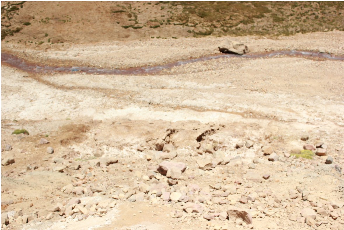
Imagen 8. Cárcavas en el talud hacia el Río Estrecho, evidencia de escurrimiento de aguas de contacto.
