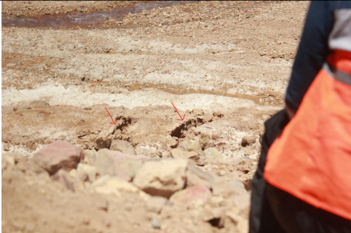
Imagen 9. Cárcavas en el talud hacia el Río Estrecho, evidencia de escurrimiento de aguas de contacto.
